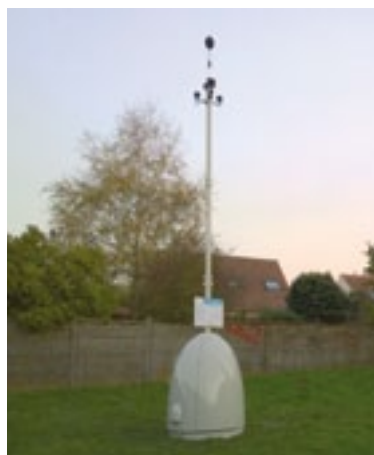
Sonopode installé à Saint-Mesmes (77)
